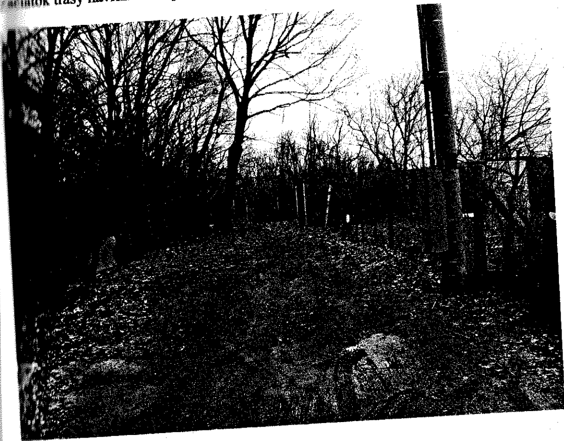
ukončenie trasy kanalizačného potrubia
